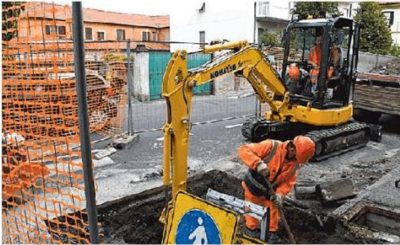
Gli operai al lavoro per riparare il cedimento fognario in via Ferrini
