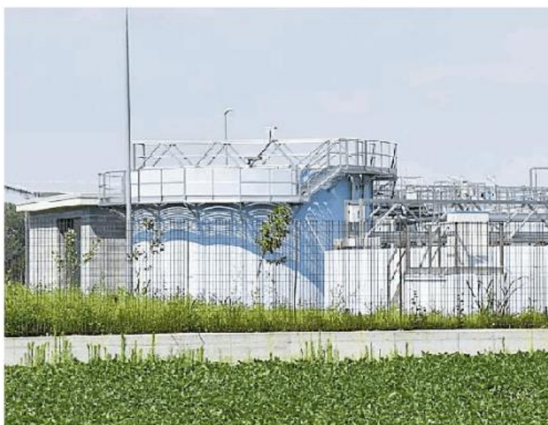
Il nuovo depuratore di Casorate, in località Cascina Morivione
