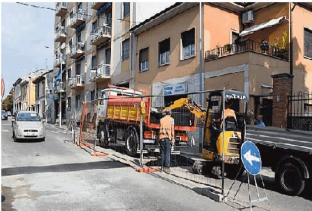
Operai al lavoro ieri in via San Pietro
