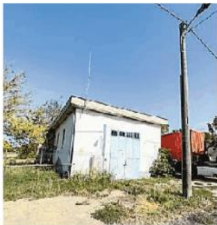
L'acquedotto di Santa Giuletta
