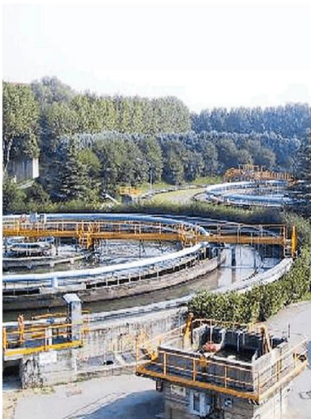
Il depuratore di Montefiascone a Pavia
