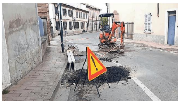
Lavori all'acquedotto in una strada di Montebello
