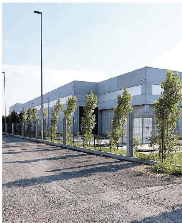
L'impianto di Agririsorse per il trattamento dei fanghi
