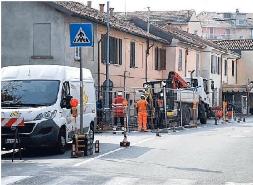
Aperto ieri il cantiere per rifare le fognature
