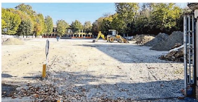
Il cantiere nel cortile nord dell'ex caserma di cavalleria
