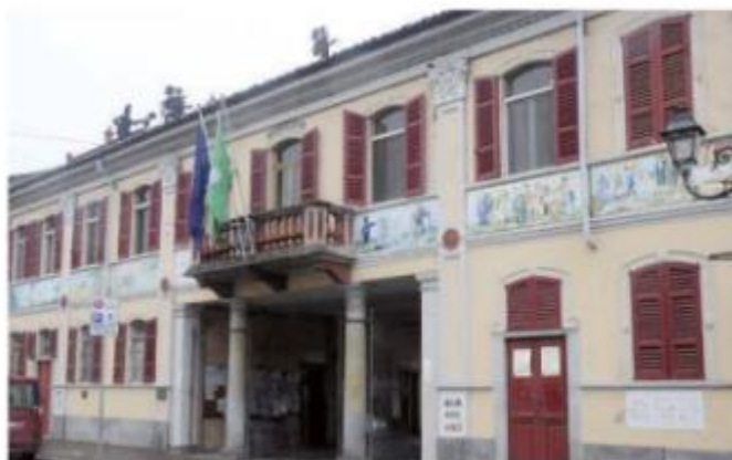
Il Comune di Gravellona vuole realizzare una comunità energetica
