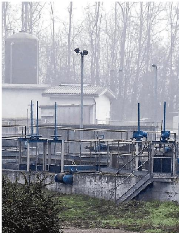
Il depuratore di Belgioioso ha un impianto fisso di controllo
