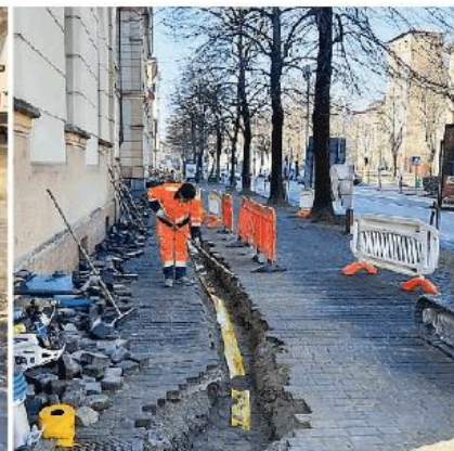
Lavori del gennaio scorso per la posa della fibra ottica
