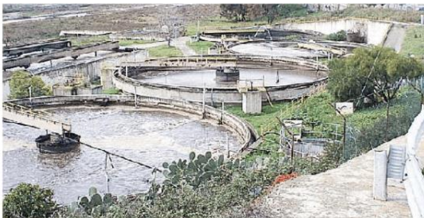
Previsti interventi di potenziamento al depuratore di Cava Manara
