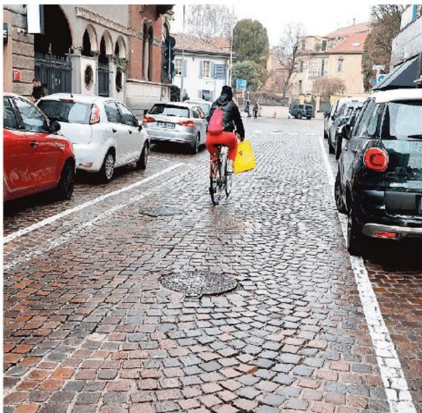
Verrà chiuso per lavori il tratto di via Cairoli compreso tra la stazione e l'incrocio con via Rocca Vecchia
