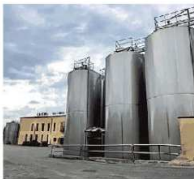
I silos della cantina Terre
