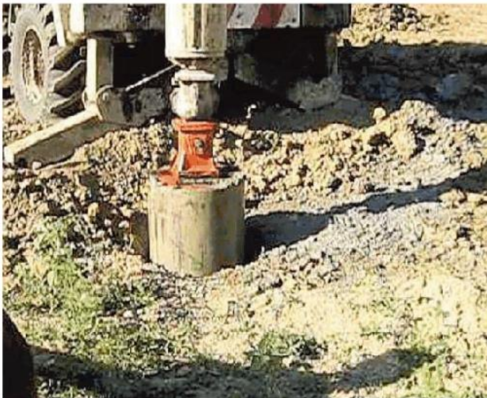
Una fase di scavo di un pozzo (foto archivio)
