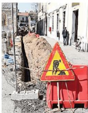
Il cantiere di via Cattaneo
