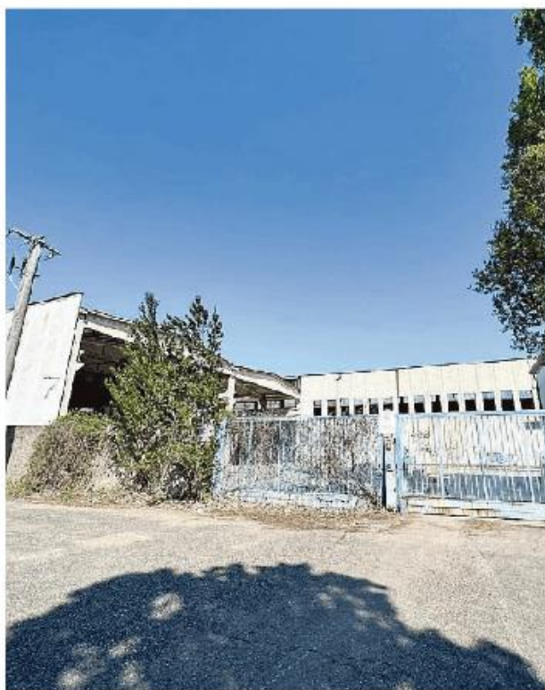
L'ingresso della fabbrica dismessa dell'ex Cielle a Pinarolo
