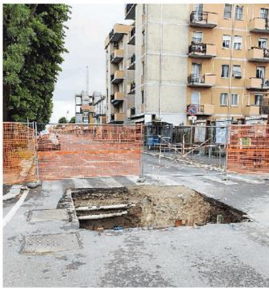
Lavori fermi, il cantiere di via Assi San Paolo deserto
