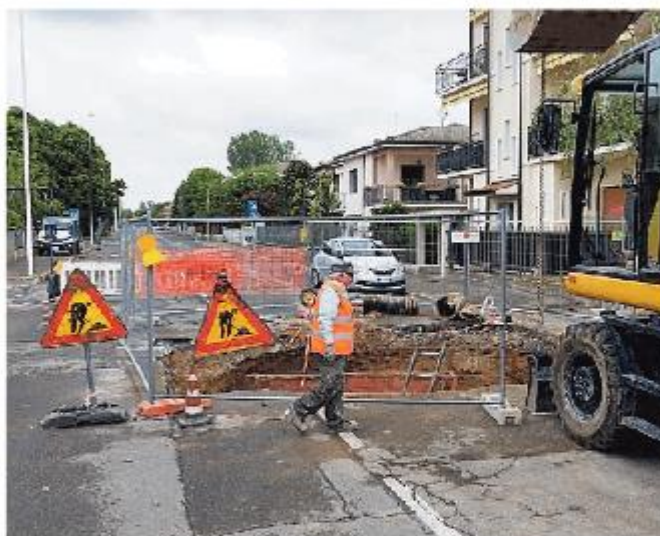
Il cantiere delle fognature che taglia in due via Pastrengo
