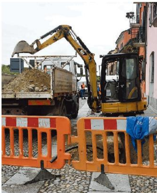
Scavi in via Milazzo alla ricerca del guasto all'acquedotto
