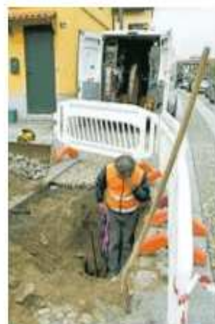
Al lavoro in via Milazzo
