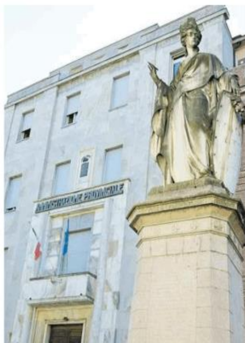
La sede dell'amministrazione provinciale in piazza Italia
