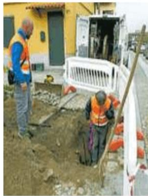
Lavori Asm in via Milazzo
