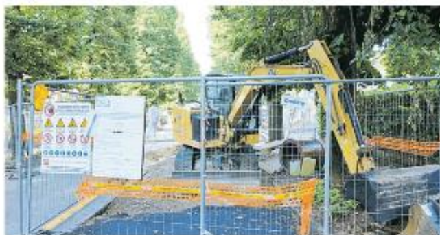
Lavori alla rete fognaria nel viale che porta verso il monastero
