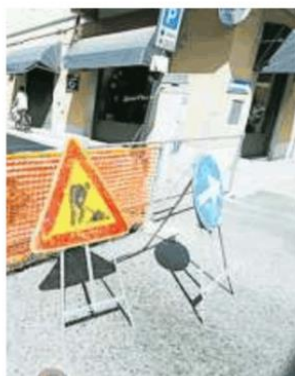
Corso Josti chiuso per lavori
