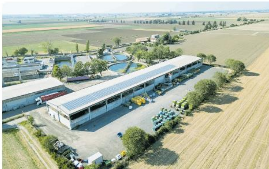
Una vista dall'alto della zona del depuratore dove vengono temporaneamente portati i rifiuti
