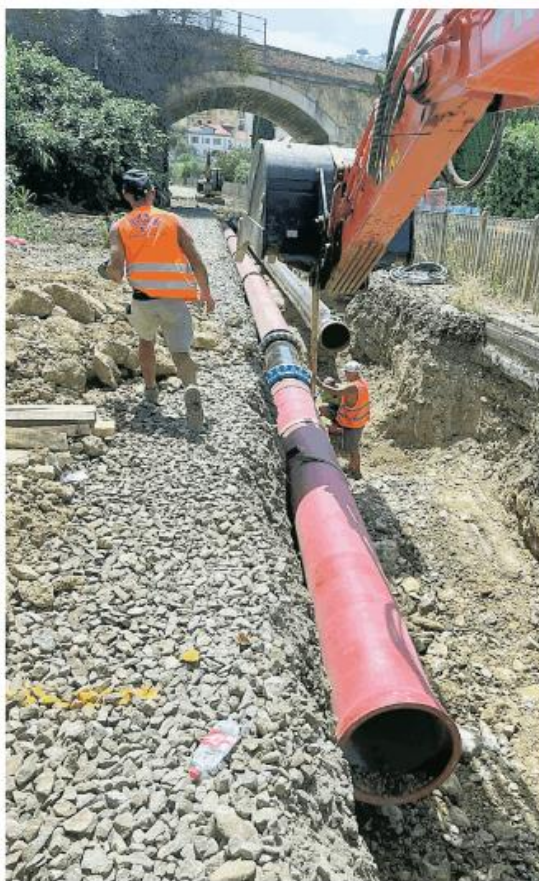
I lavori di realizzazione di un acquedotto (foto d'archivio)
