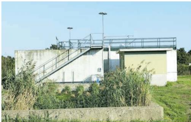
Il depuratore di Bereguardo sarà demolito e sarà realizzato un nuovo impianto
