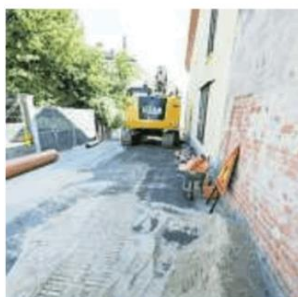
Lavori alla frazione Balossa
