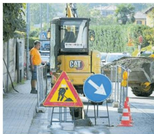
Il cantiere in via Milano a Castel Lambro, frazione di Marzano
