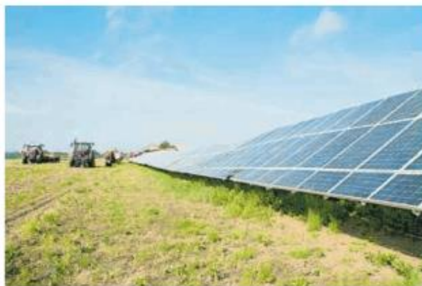
Una installazione di pannelli fotovoltaici in un campo agricolo
