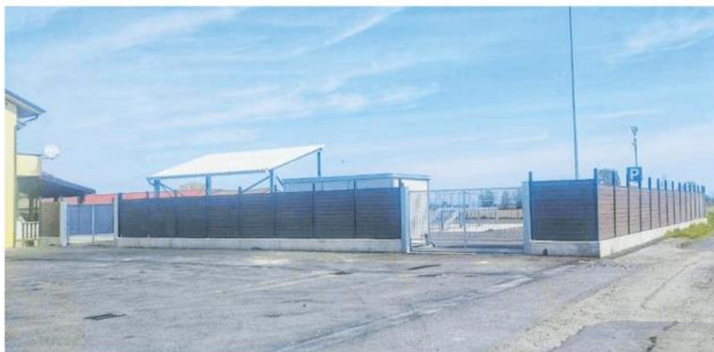
La piazzola ecologica per la raccolta dei rifiuti realizzata ad Olevano e mai entrata in funzione: il progetto è stato redatto dalla "stC" di S. Genesio
