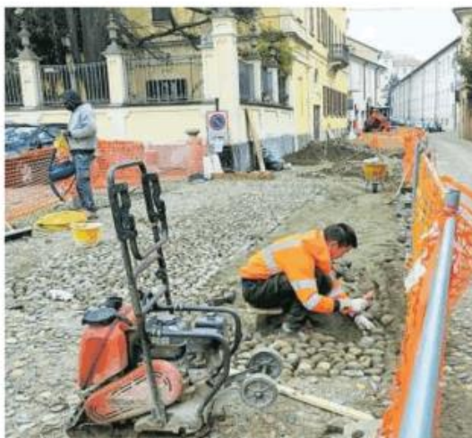
Operai al lavoro per il rifacimento dell'acciottolato in piazza Ghislieri
