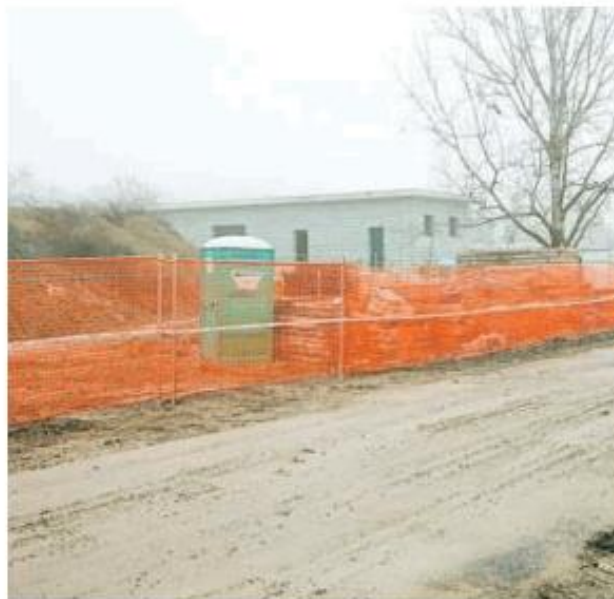
I lavori per il collegamento degli scarichi di otto Comuni
