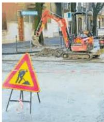
Lavori per l'acquedotto
