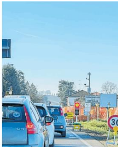
Il cantiere a Montebello
