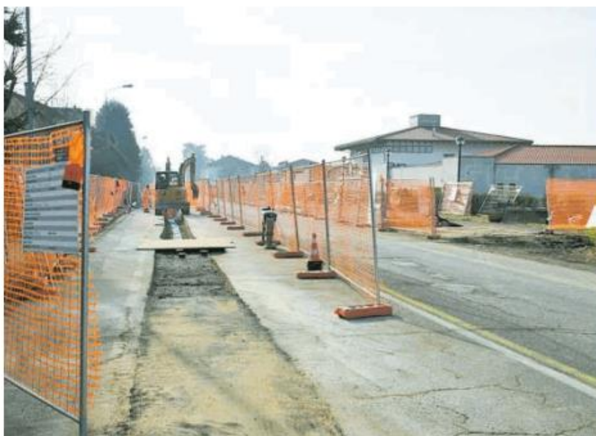
Il cantiere di Pavia Acque a Montebello sarà riproposto per tutta via Piacenza a Voghera
