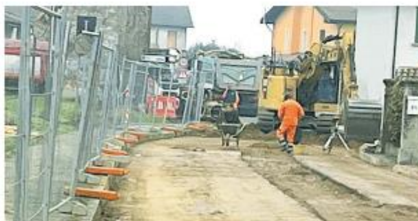
La preparazione del cantiere alla frazione Bolognola
