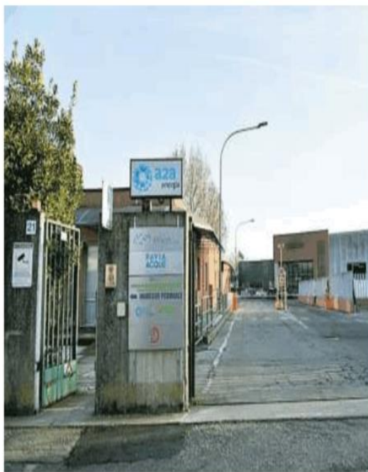
Una delle piattaforme sarà nel perimetro di Asm in via Donegani
