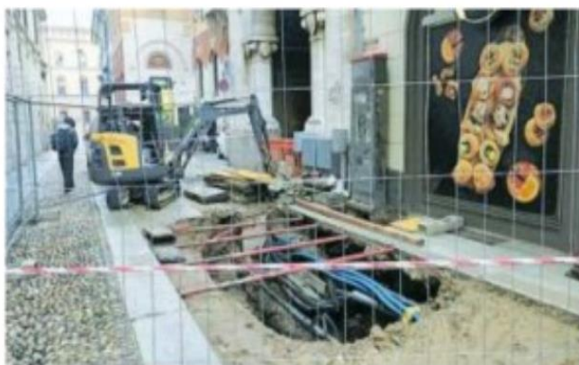
Lo scavo per sistemare la fognatura che ha ceduto: se ne occupa Asm
