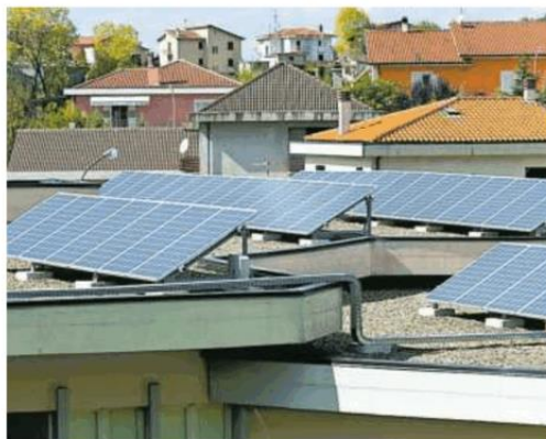
Pannelli fotovoltaici sui tetti: il progetto arriva a Torrazza Coste
