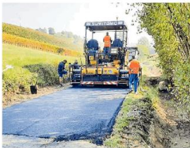
Ripartono le asfaltature a Stradella anche in via Rividizzolo
