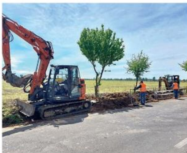
Gli operai al lavoro nel cantiere per la rete fognaria
