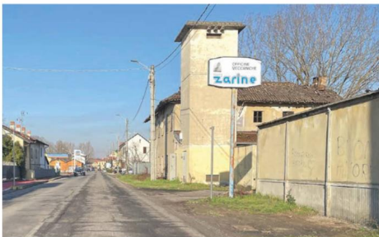
La ex fabbrica Zarine è situata in Strada Pavese ed è dismessa da decenni
