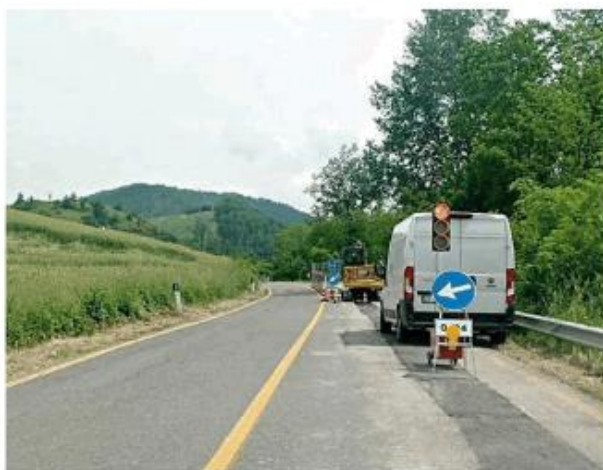
Lavori alla rete idrica a Val di Nizza, lungo la strada provinciale 7
