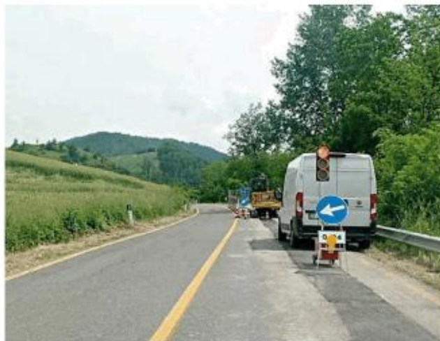
I lavori alla rete idrica a Val di Nizza, lungo la strada provinciale 7
