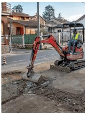
Un cantiere di Pavia Acque
