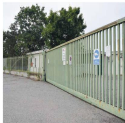
L'impianto di depurazione acque di via Aguzzafame
