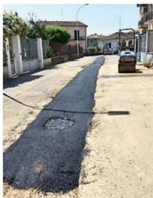
Il cantiere chiuso in via Lomellina
