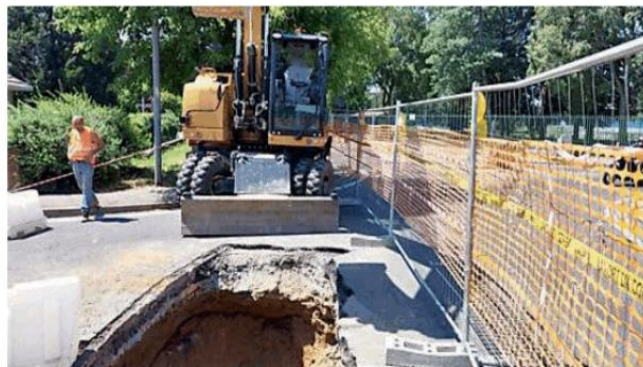
Gli scavi aperti in via Treves per riparare il cedimento della fogna
