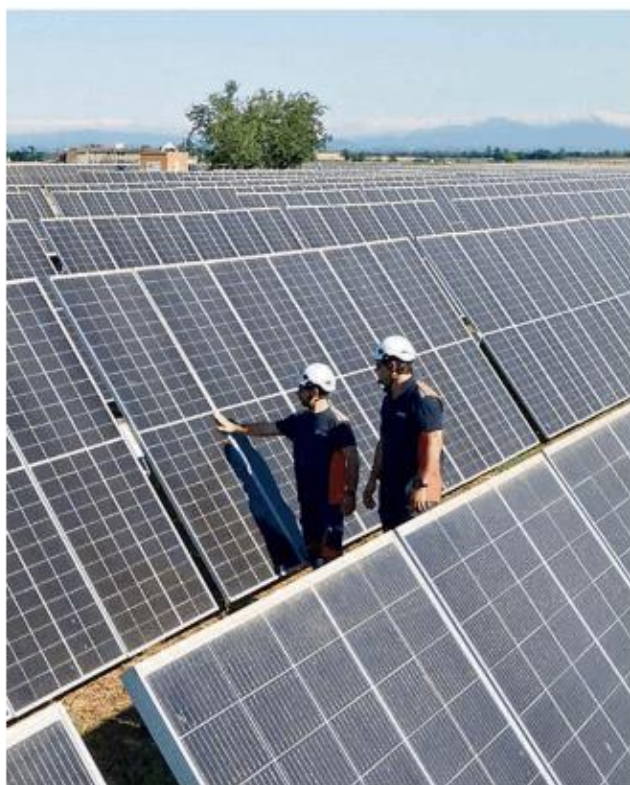
Tecnici al lavoro su pannelli solari
