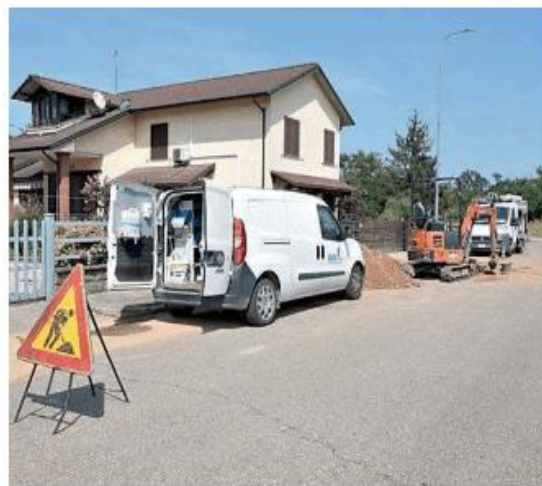
Lavori in via Meazza per riparare il guasto alla rete idrica
